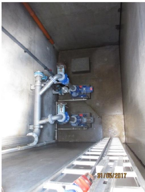
Abbildung 2 - links: Blick in das Pumpwerk (oben Pumpe 1, unten Pumpe 2)
