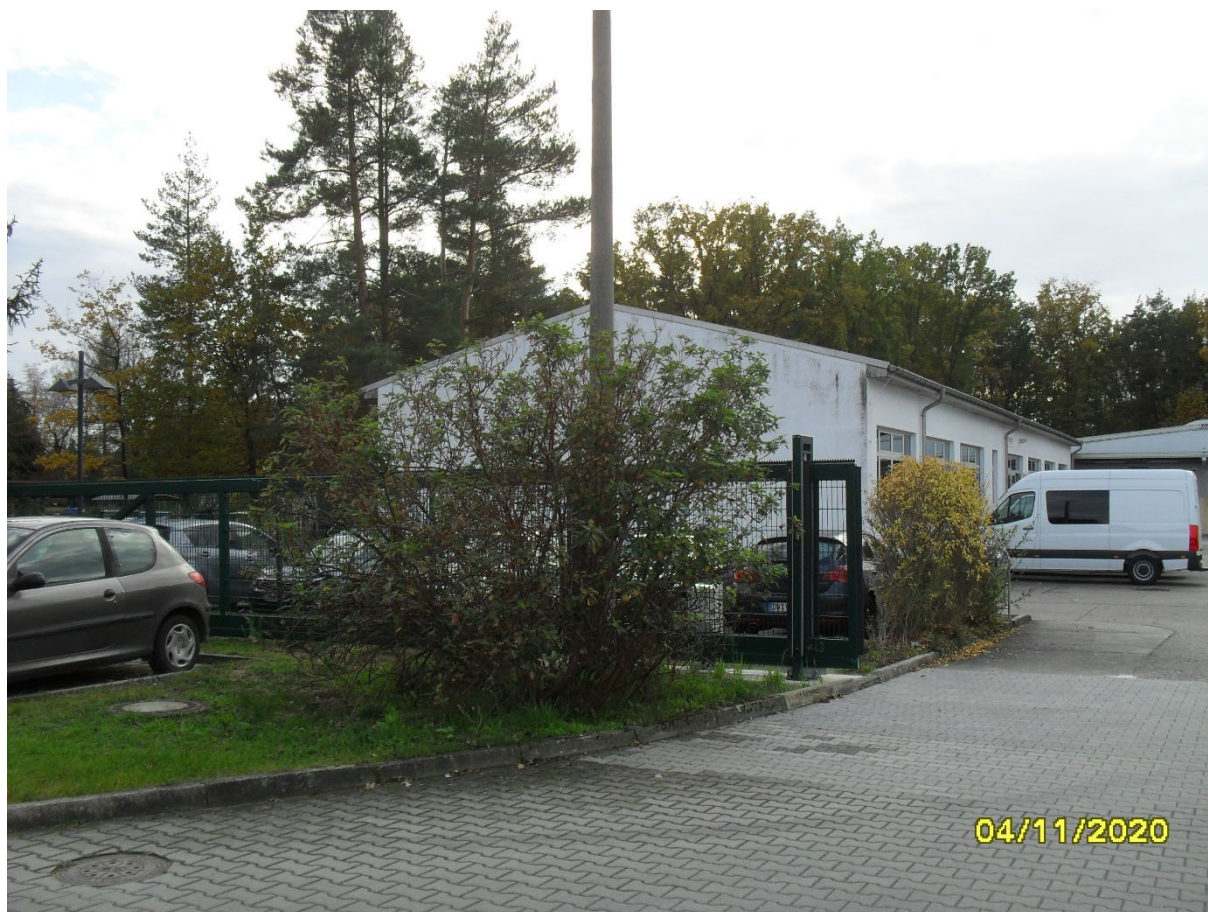
Foto 3: versiegelte Zufahrt zum Betriebsgelände mit Hallenkomplexen und Park- bzw. Logistikflächen, eingezäuntes Gelände
