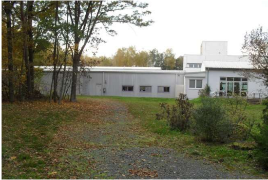
Abb.: Lagerhalle & Rückansicht Mitarbeiterkantine
