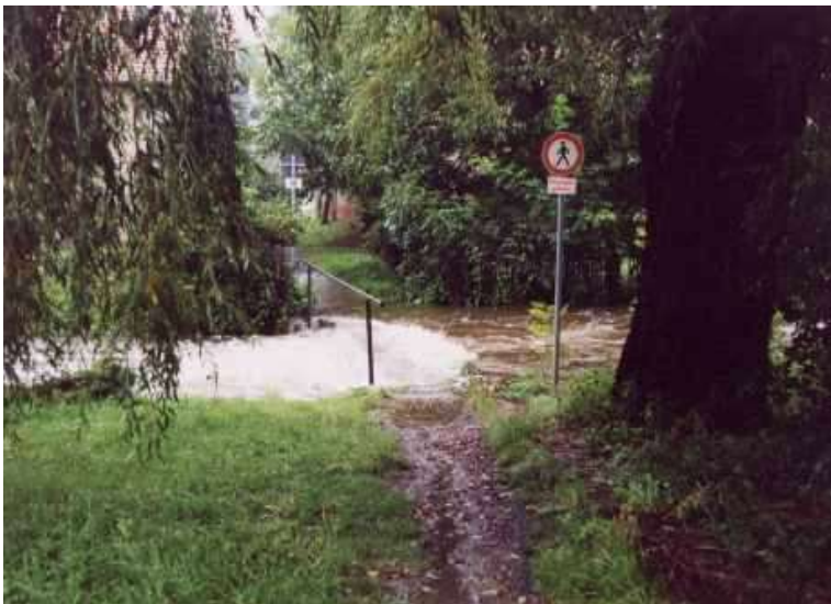
Abbildung 4-11: Fußgängerbrücke bei Bushaltestelle 19
