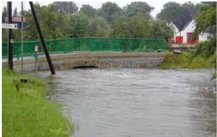
Abbildung 4-13: Brücke Richtung Bärwalde, Blickrichtung Süd 21
