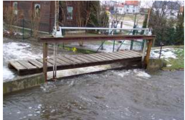
Abbildung 3-4: Wehr Berbisdorf bei Hochwasser
