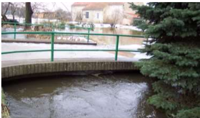
Abbildung 4-27: Oberstrom Brücke zur Straße An der Promnitz, Blickrichtung Südwest 8.2.06, 11:03 Uhr
