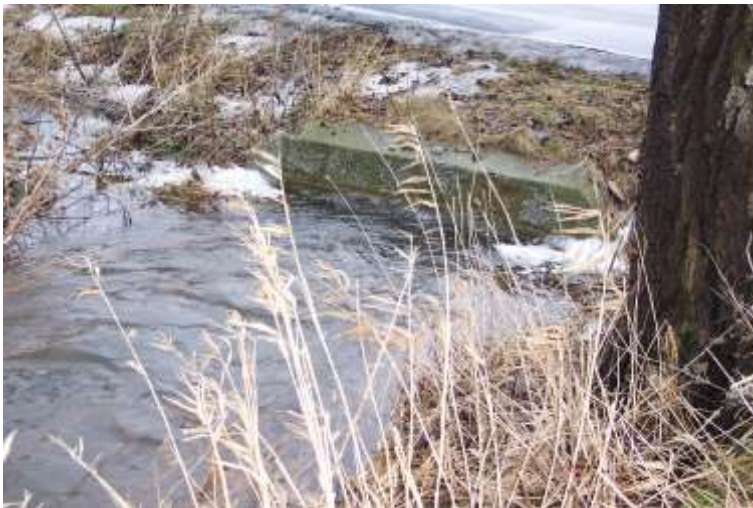
Abbildung 4-24: Durchlass Bartlake unter S 96, Blickrichtung Nordost – 8.2.06, 9:45 Uhr
