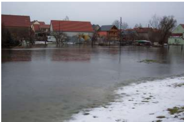
Abbildung 4-35: Ausuferung entlang des Dammweges, Blickrichtung Südost 8.2.06, 12:44 Uhr
