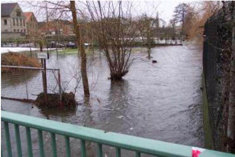
Abbildung 4-38: Oberstrom Fußgängerbrücke (Volleinstau) Dammweg, Blickrichtung Süd 8.2.06, 12:47 Uhr
