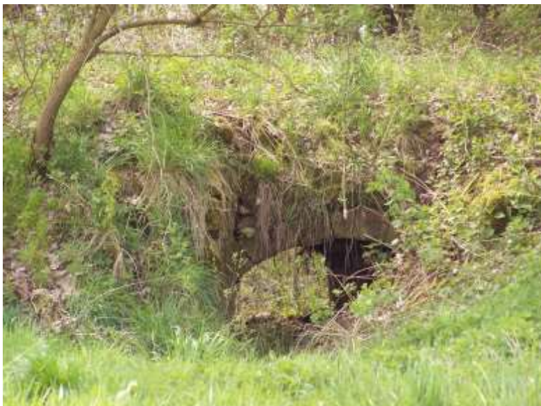
Abbildung 5-1: Durchlass Nordabfluss Unterer Großteich
