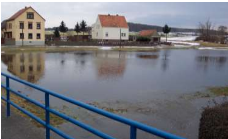
Abbildung 4-30: Oberstrom der Straßenbrücke S 80, Blickrichtung Südost 8.2.06, 11:24 Uhr
