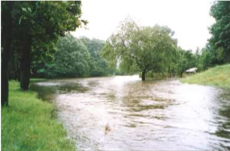
Abbildung 4-18: Promnitzau oberstrom Bahnhofsbrücke, Blickrichtung Ost
