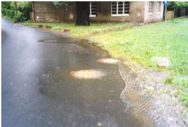
Abbildung 4-22: Ausuferung bei katholischer Kapelle, Überflutung Hauptsammler, Blickrichtung Nord
