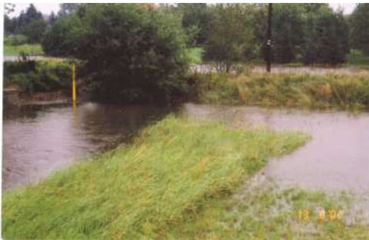
Abbildung 4-16: Mündung Börnsbach vor Kleinbahn, Blickrichtung West
