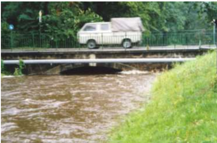
Abbildung 4-19: Brücke Bahnhofsstraße, Blickrichtung West
