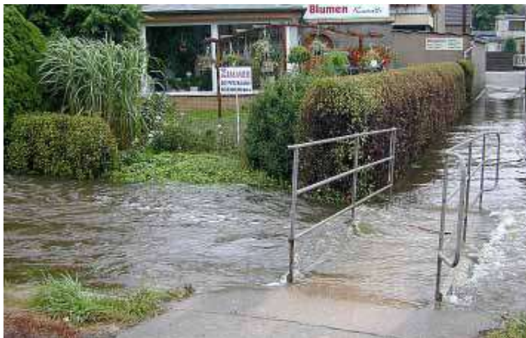
Abbildung 4-5: Fußgängerbrücke kurz unterstrom Straßenbrücke S 96, Blickrichtung West 19
