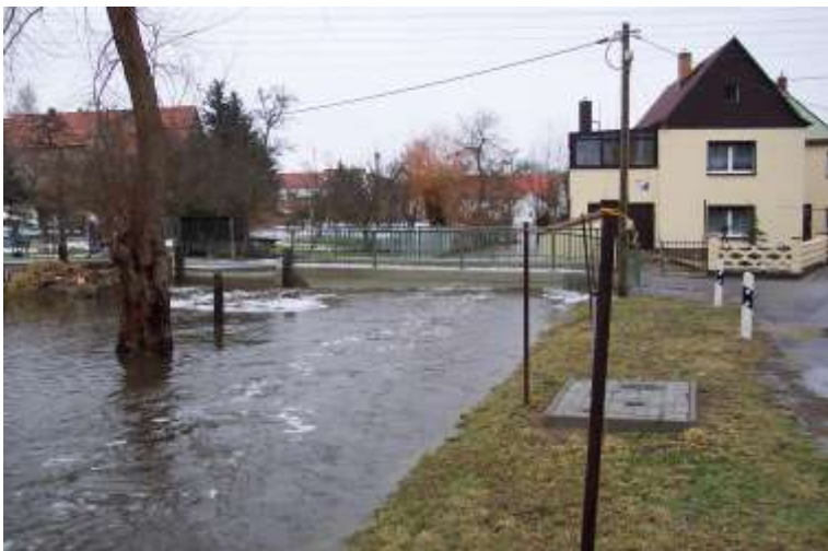
Abbildung 4-33: Volleinstau Rettungswegbrücke Dammweg, Blickrichtung Nord 8.2.06, 12:40 Uhr
