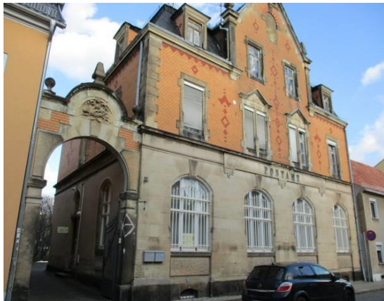
Dresdner Straße 21 (Alte Post)
